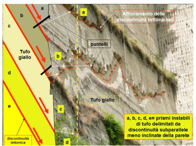
Evidenze delle fratture che immergono verso il piazzale di cava (a franapoggio meno inclinato del pendio) isolando prismi di tufo e predisponendoli al crollo come rappresentato nello schema a sinistra
