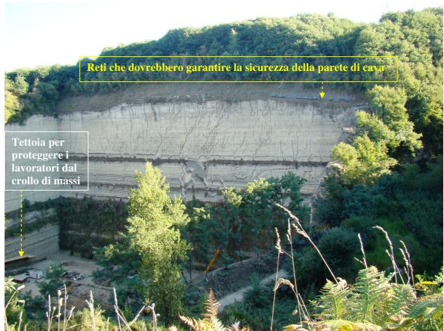
Interventi di messa in sicurezza delle pareti di tufo e dei lavoratori. Sono evidenti le fratture che interessano il tufo giallo della parete sud alta circa 70 metri. In basso a sinistra è indicata la tettoia che dovrebbe proteggere i lavoratori. La sicurezza delle pareti, secondo il progetto inadeguato,dovrebbe essere garantita dalle reti ancorate lungo la parete.
