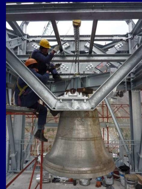
**Ricostruzione della “Torre dell’Orologio” del Castello di Gemona del Friuli con una struttura interna in acciaio (a 3 livelli), dotata di 22 dissipatori BRAD (lunghezza = 1,49 m, diametro esterno = 213 mm). Per evitare *martellamento* con la parte esterna in muratura, il giunto strutturale è di 10 mm alla base e 17-20 mm alle quote superiori.**
