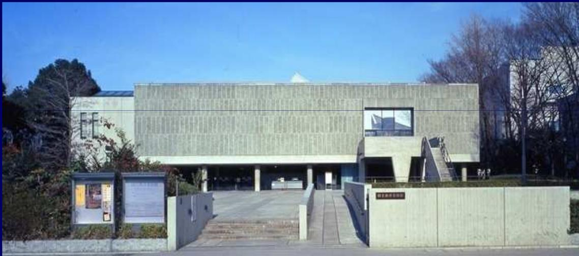
***National Western Art (Le Corbusier) Museum di Tokyo (4 piani), adeguato sismicamente con HDRB in sottofondazione nel 1999: il sistema d'isolamento ha ridotto l'accelerazione orizzontale massima del terreno da 0,19 e 0,28 g alla base a 0,08 e 0,10 g alla sommità***
