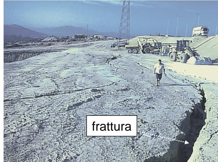
Foto 13 - In primo piano si vede la fratturazione secondaria che ha interessato la parte in piano dell'argine di monte; lo scalino di circa 1 metro visibile sul fondo è la frattura principale segnata in linea rossa sul disegno nella parte a monte.
